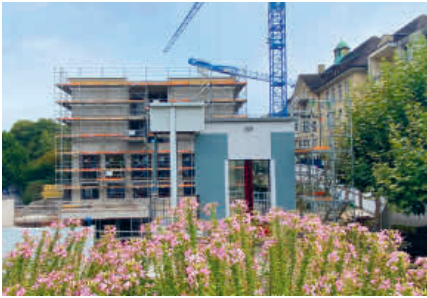
West-Ansicht auf das «Mock-up».
