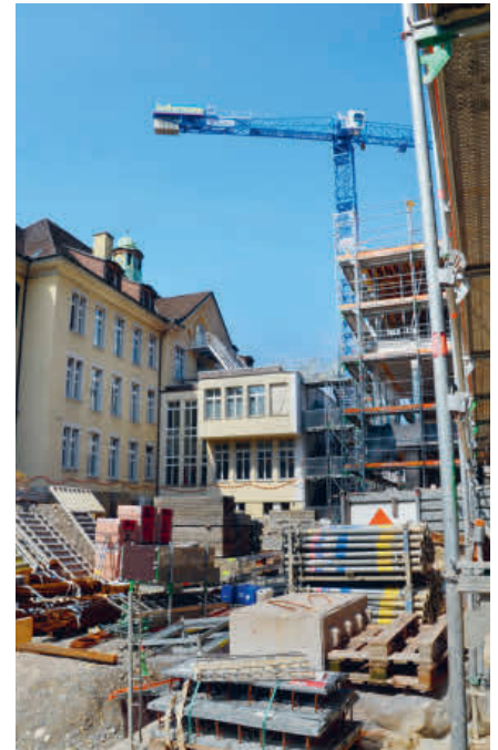
Der Rückbau des kleinen Reststücks «Anbau Nord» erfolgt zu einem späteren Zeitpunkt.
