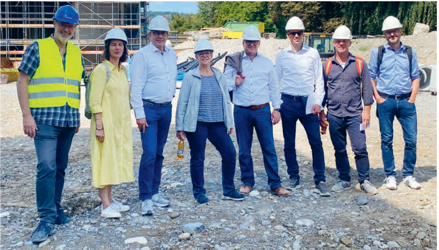
Der Stadtrat Baden besucht die RPB-Baustelle; es fehlt Ruth Müri.
