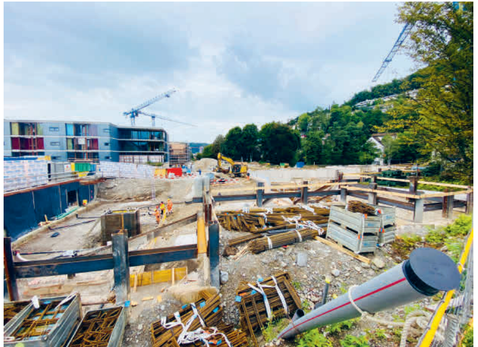
Die Aushubarbeiten für die Alterswohnungen sind erfolgt – die ersten Wände im Untergeschoss entstehen.
