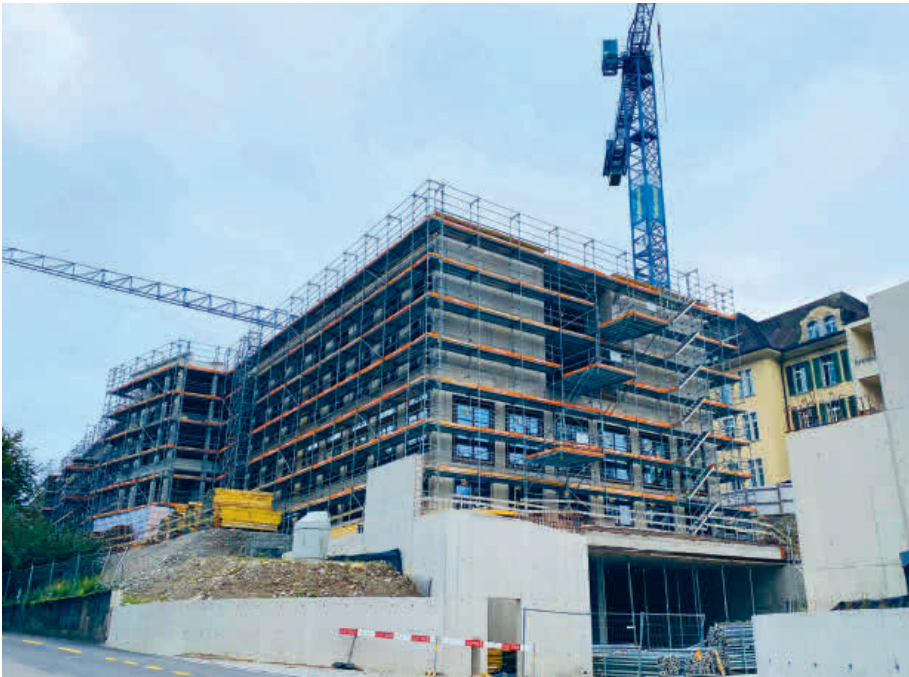
Blick von der Schartenstrasse auf den künftigen Saal und Pflegeabteilungen.
