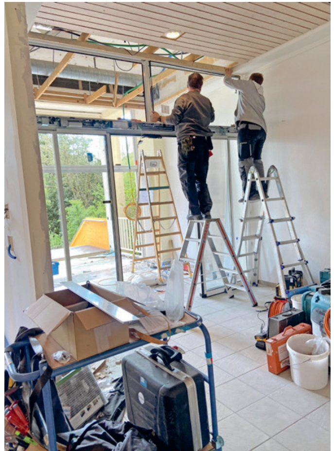
Die Türen für den Windfang werden montiert.
