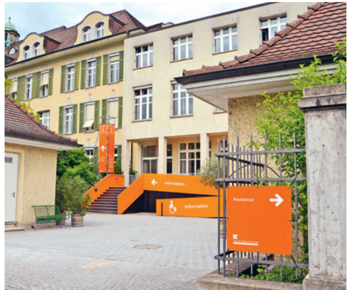
Der neue Zugang zum Areal.
