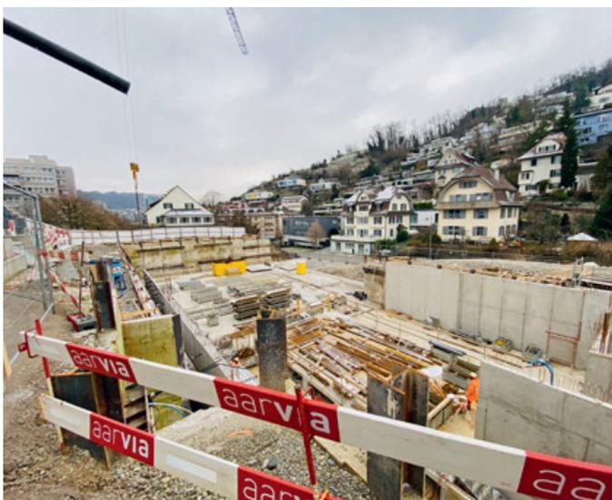
*Wände des 2. Untergeschosses Baustrakt A werden errichtet*
