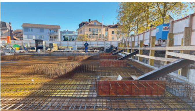
Stahlgitter für die Betondecke der Tiefgarage
