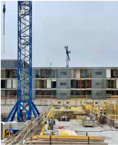
Decke der Tiefgarage wird erstellt
