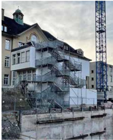
Nord-Ansicht: Notausgangstreppe Palace
