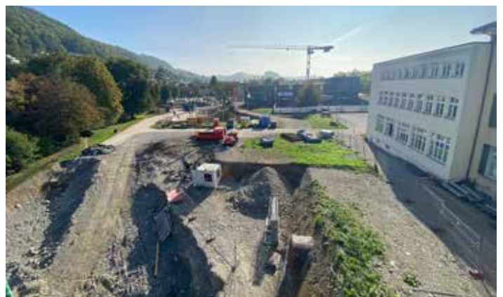
West-Ansicht Baustrakt A
