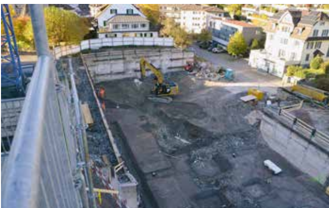
Vorbereitungen Baustrakt A
