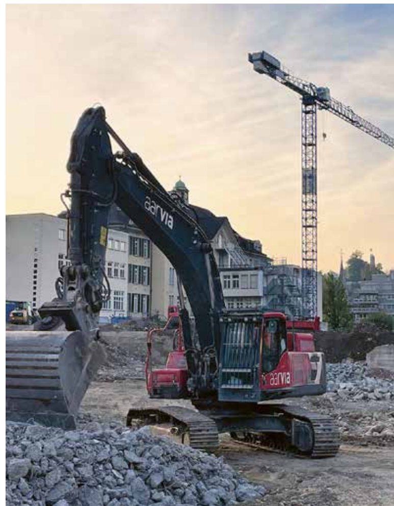
Diverser Schutt wird abgetragen.
