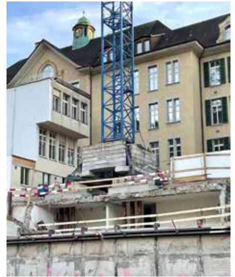
Nord-Ansicht Palace mit Rühlwänden der Baugrube an der Scharthenstrasse
